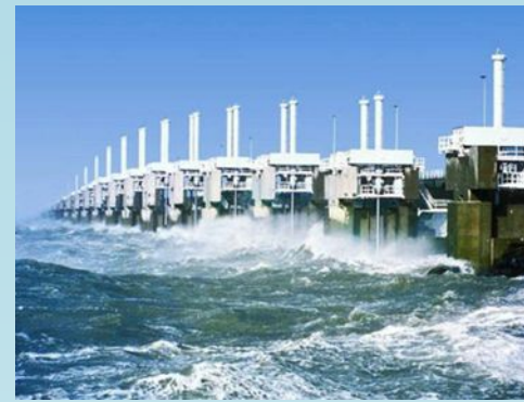
Storm Surge Barrier, Neeltje Jans
